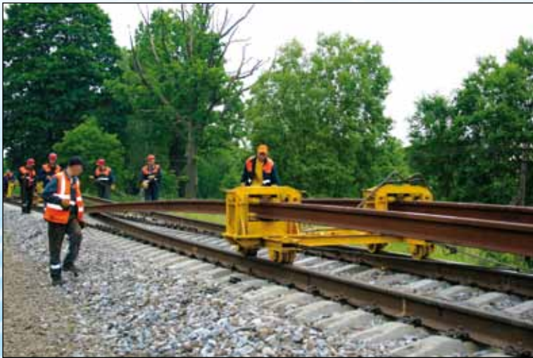
拉铁线路现代化改造（拉脱维亚）
